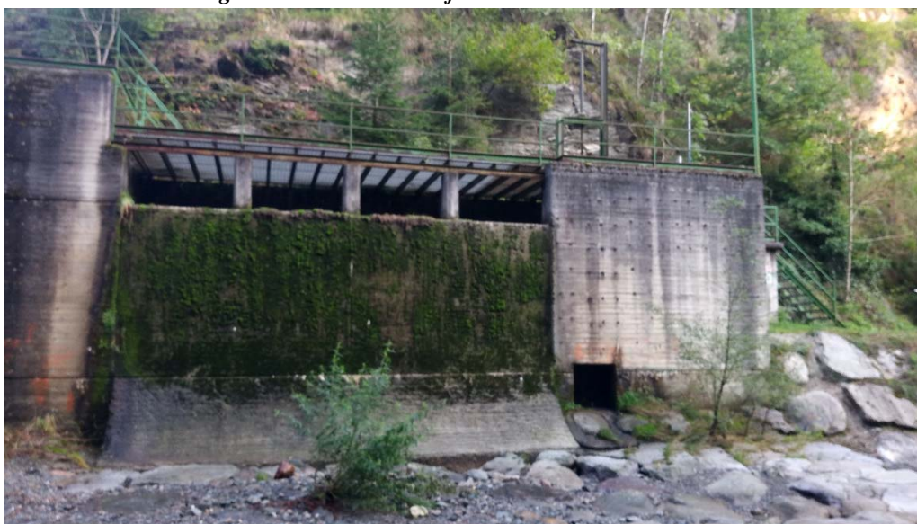
Figura 6: Vista del manufatto del dissabbiatore
